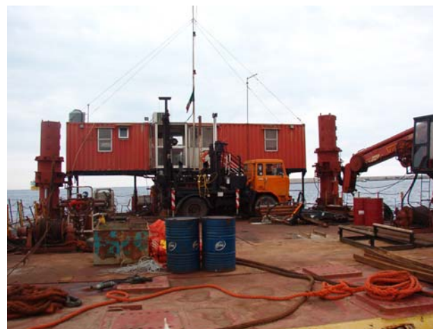
Allestimento della piattaforma con penetrometro e attrezzatura accessoria
