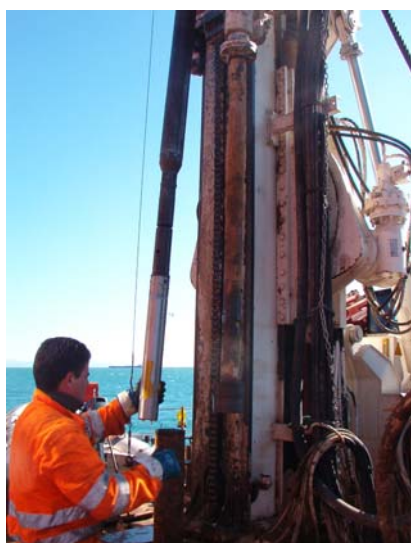
Esecuzione di perforazione verticale
