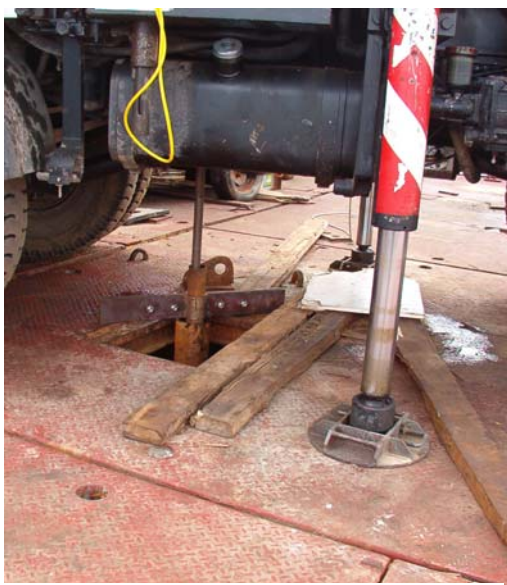
Esecuzione prove dilatometriche.
